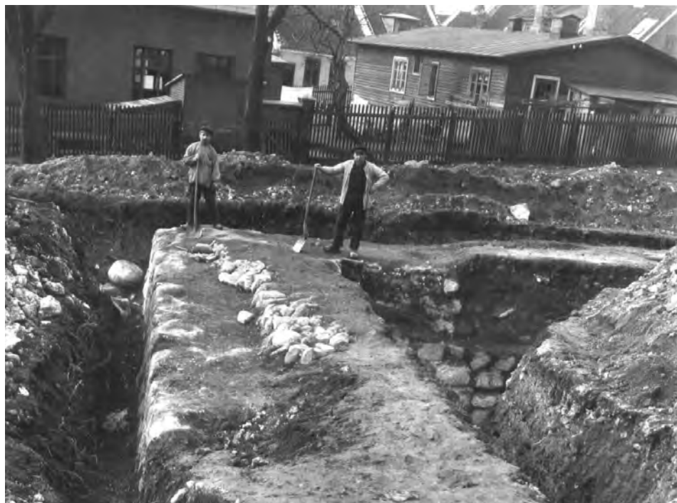
Fig. 6. Udgravningen af det store tårn Folen i 1926. De to arbejdere står oven på de mægtige fundamenter, der er ikke mindre end 3,3 m brede. (Foto: Nationalmuseet)
