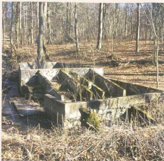
Betonfundamentene i Klinteskovens en martsdag i 2005. De rummer fortællingen om en iværksætter, der forstod at tackle miljømæssige ændringer i omgivelserne til gunst for sit erhverv. Foto Lisbeth Pedersen.
