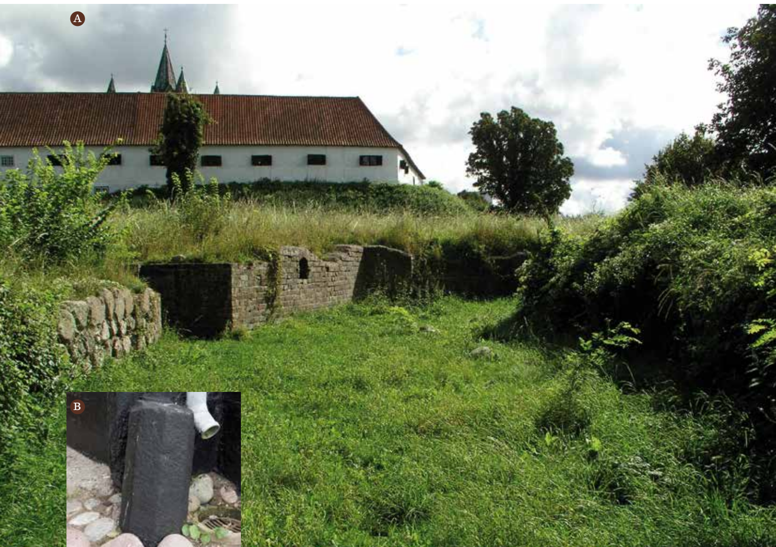
Fig. 7. Vestborgen, 2007. A: Ruiner af Ingeborg Snaredatter og Peter Strangesens stormandsbolig set fra vest. Fundamenterne til deres fornemme hovedbygning på borgen var på daværende tidspunkt delvist skjult af træer og buske, hvis rødder ødelagde murværkerne. På kanten af Højby-banken ligger Lindegården med Kalundborg Museum, og
